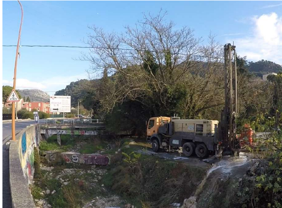
Atelier de forage à proximité du vallon du Laghet
