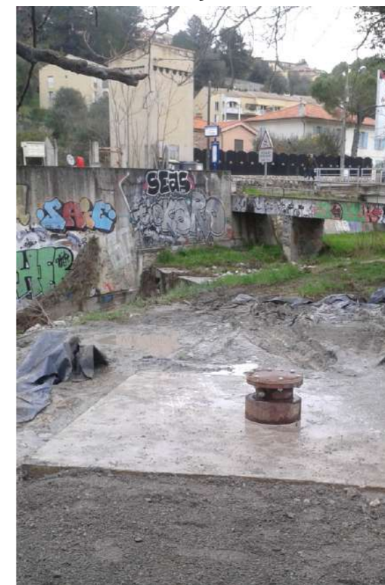
Tête de forage après travaux
